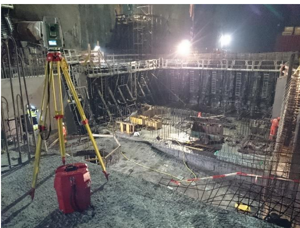
Implantations de la chambre d'épanouissement des groupes.
