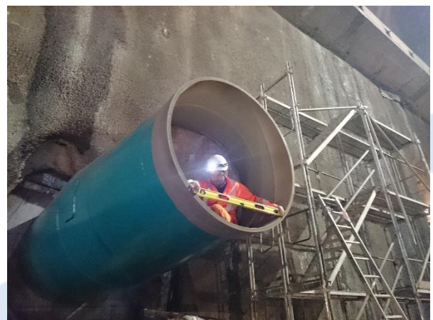
Contrôle de l'axe des conduites.
